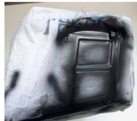
Die Fensterrahmen werden schwarz seidenmatt lackiert
